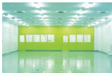
乱流方式クリーンルーム
