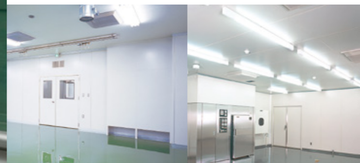
[CR-1、SAT] 壁パネルと一体化したリターンダクト。 [CR-1、CR-C2、PAT]
