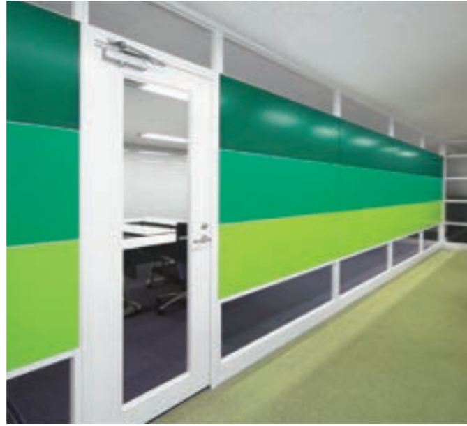
カラフルな色彩のブロック意匠により、壁面にありがちな閉塞感や無機質さを解消。
