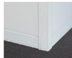
2WAY部(柱下部)
