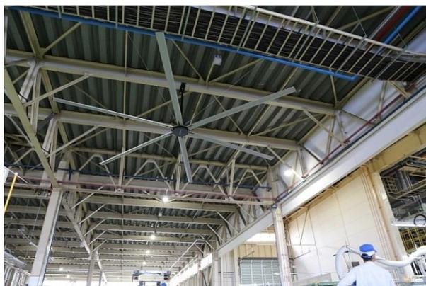
大型シーリングファンとは、巨大な羽根を低速で回転させることにより多くの空気をとらえ、天井が高く、面積が広い空間でも空気の対流を生むことができ、大規模な風の流れを工場内に作り出すことができます。
