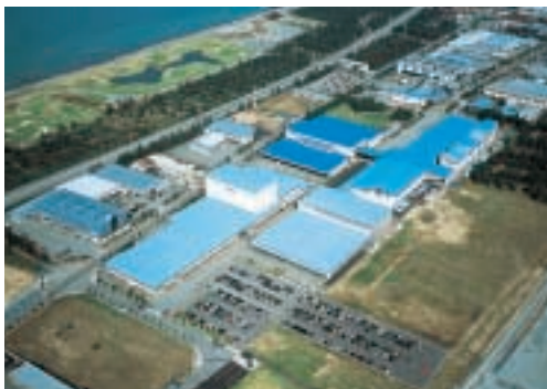
本社および本社工場
