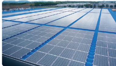
本社工場屋根への太陽光パネルの設置
